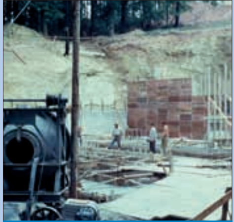
Neubau Hochbehälter Moggenbrunnen 1960
